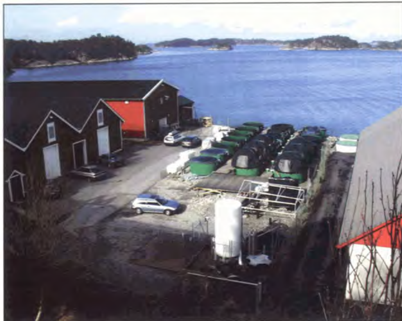
Havbruksstasjonens landbaserte forskningsfasiliteter på Sauaneset. (Foto: Torfinn Grav)
