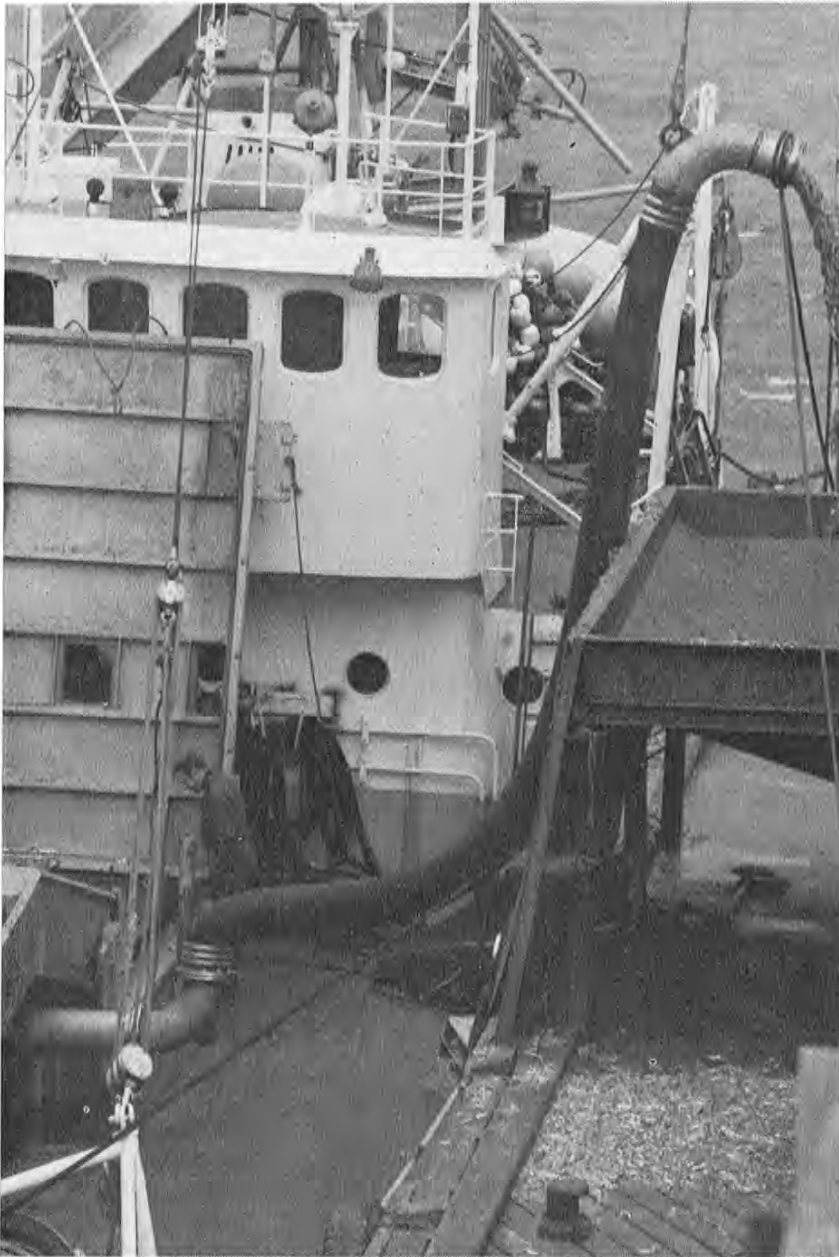
«Husby» lossers ved hjelp av pumpe ved Vadsø Sildoljefabrikk. (Foto: Olav Meland).
