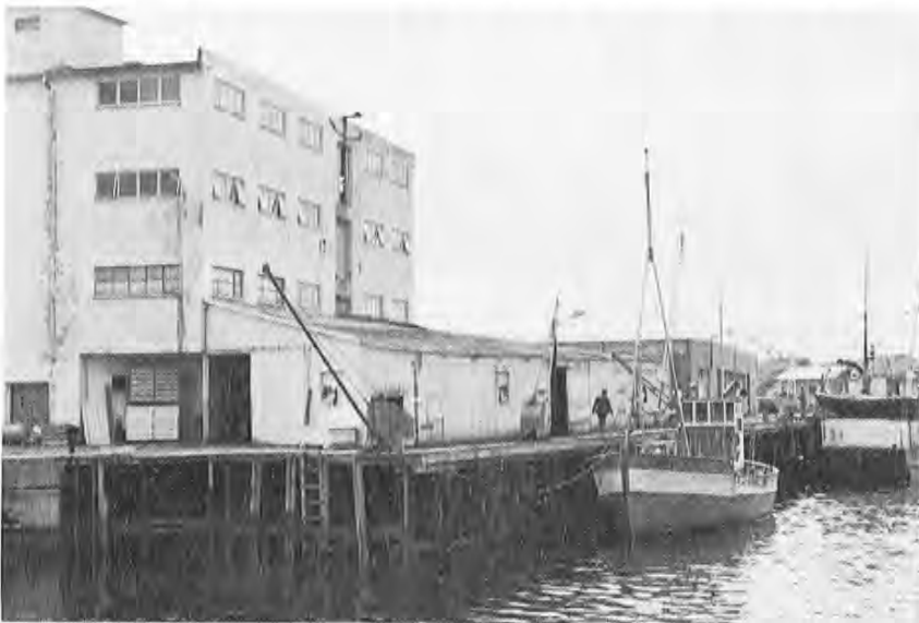
Dette er Moskenes Fiskeindustri A/S som er i gang med omfattende utvidings- og moderniseringsarbeider. Det lave mottaksskuret og trekaaien skal bl.a. rives og erstattes av ny hall og betongkai. (Foto: Carl Inge Veland).
