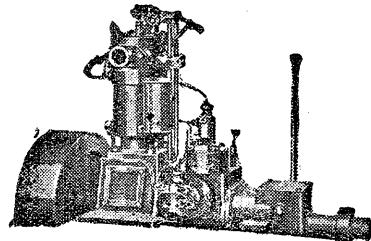
5-7 hk. "Marna" Diesel, system Aero. Brenselforbruk 1,2 kg rå-
