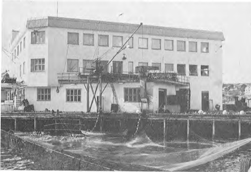
Dette er Rørvik Fiskeindustri i Nord-Trøndelag som nå er i ferd med å utvide og modernisere. I forgrunnen ser vi levendesei-noten og kranen som blir brukt til inntak.
