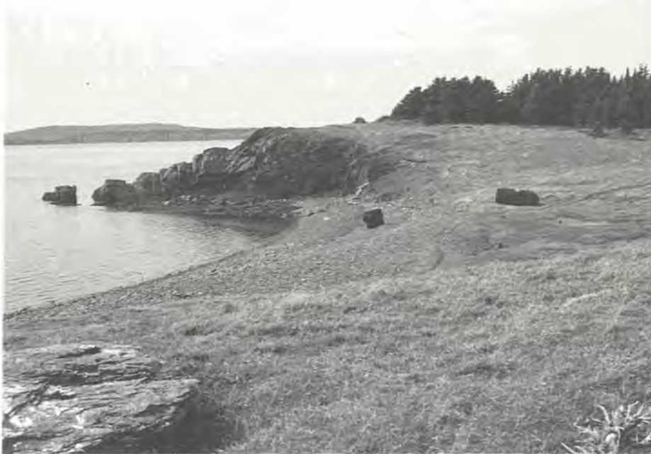
Bukta der utklekkingsanlegget Dildo Hatchery ble bygd i 1889. Vi kan så vidt skimte rester av en mur og to pumper.
