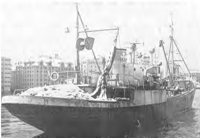
En typisk representant for de eldste snurperne som ble ombygd til ringnotdrift i 1960-årene var «UTVÆR» av Ole Solbjørg A/S, Ålesund. Fartøyet som var 120,0 fot l.l. og målte 187 brt, var opprinnelig bygd i 1914 ved Kristiansands Mek. Verksted som dampdrevet fiskefartøy. Fartøyet fikk innsatt dieselmotor i 1952. Kondemnert og gikk ut av ringnotflåten i 1971. Bildet er tatt på Bergen havn av Dag Bakka jr.
