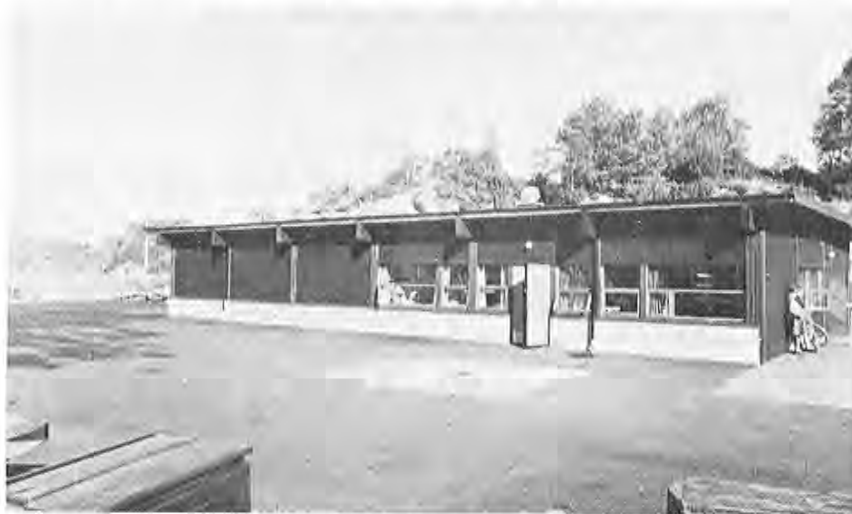
Stasjonsbygningen er konstruert slik at den lett kan gjøres dobbelt så stor. Flytebrygge og mærer i bakgrunnen til venstre.
