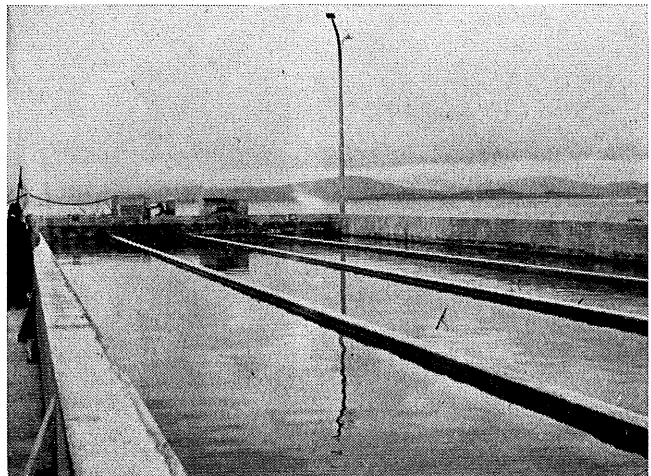
Fig. 8. Tanker i et renseanlegg for blåskjell.
