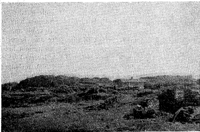
Mellom de sprengte grunnene reises små arbeidsbarakker.
