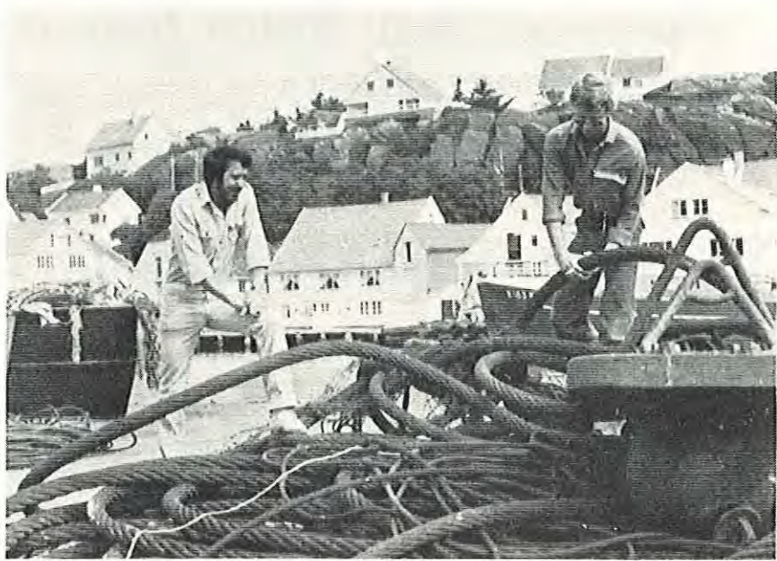
Konsulent Munkejord måler en wire; Denne størrelsen brukes bare i olje- industrien.
