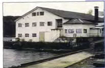
Norway Foods-fabrikken i Askvoll er den fabrikk som sist vart lagt ned. Askvoll kommune prøver å låne ny drift i fabrikk. Greier dei ikkje det, vil fabrikken forfalls.
