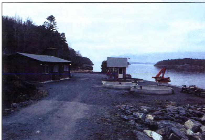
Figur 4. Firmaet «Sydnes Skjell og Fisk» på Halsnøy i Sunnhordland har nylig bygget opp et mottaksanlegg for skjell. Anlegget har betongtanker nedsenket i bakken, og vanninntak med sandfiltrering. Tankanlegget med filtrering gjør det mulig å samle opp større partier med skjell og holde dem i lang tid i vann som er fritt for giftalger. (Foto; S. Mortensen).
