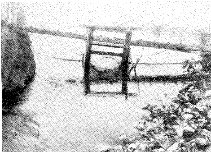
Fig. 11: Nedgangsruse bygget fast i provisorisk bro over elventløpet.
