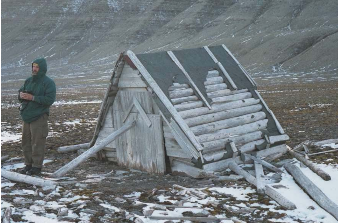
“Camp Skakk” på Egsetstranda. Foto: 13/9-1998 HKB (N98-10-12)
