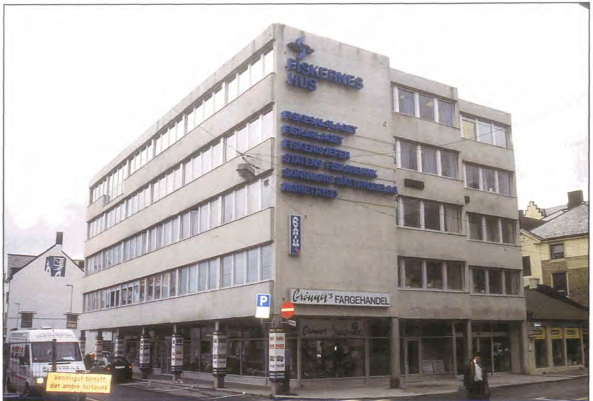
Fiskernes Hus. I løpet av året skal alt i hele bygningen være fiskerirelatert, gjennom samlokalisering av fiskerisjef og kontrollverk.
