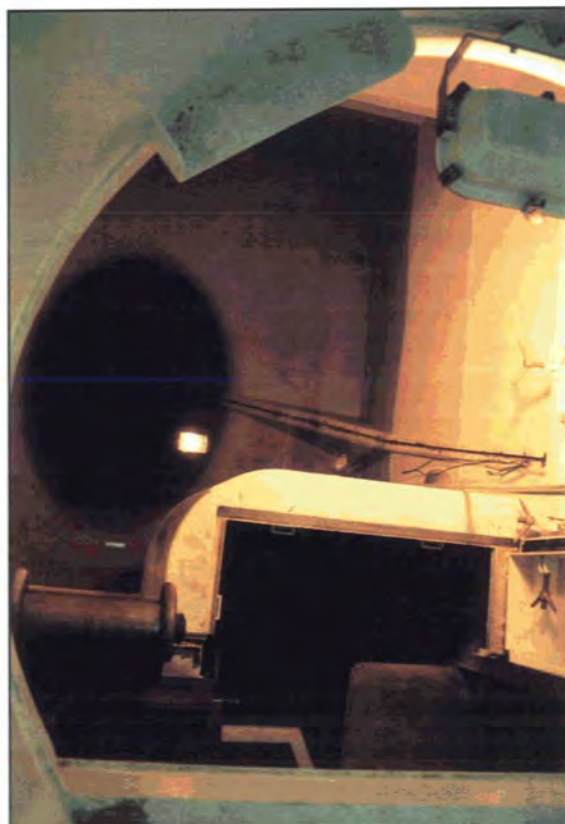
Dragerbrønn sett ovenfra med linerull plassert.
