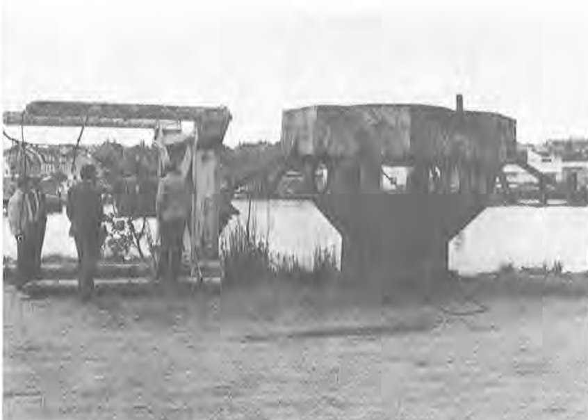
Disse jernkonstruksjonene var etterlatt på 25/11-3.
