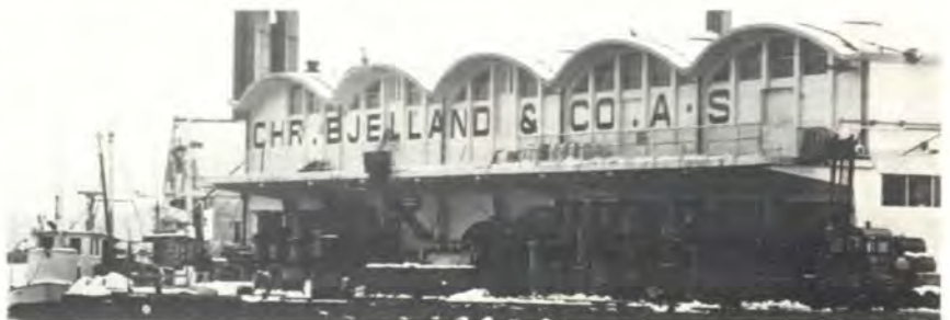
En av Chr. Bjelland & Co. bygninger som i dag benyttes som lager.
