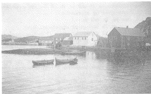
Anlegget sett fra nord.
