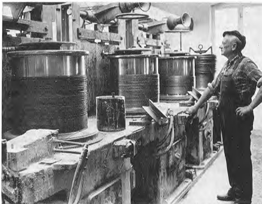
Mustad har eget trådtrekkeri for behandling av ståltråden til krokproduksjonen. Det blir kjøpt inn tråd i fire dimensjoner, og tråden blir så trukket om til 90—100 forskjellige dimensjoner, helt ned til 0,5 mm. I tillegg blir tråden varmebehandlet for å oppnå riktig struktur og strekkfasthet. (Foto: Lars Rivenes).
