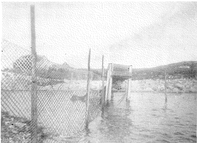
Nedgangsruse fra Mollenbukta, Trøndelag.
