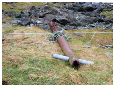
Figur 25: Havarert og mangelfull fortøyingspåle
