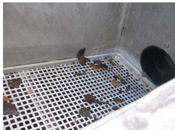
Figur 8: Fastskrudd rist i dødfisksamler
