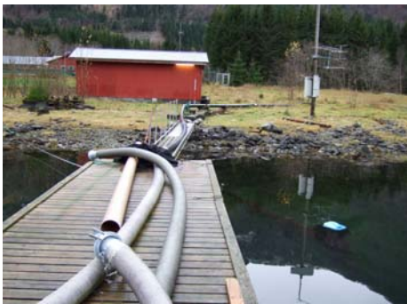
Figur 30: Lange avstander fordrer mange rørsjøter
