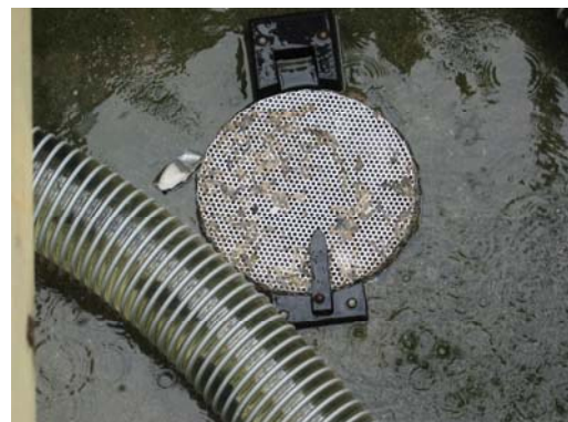
Figur 12: Sikring av avløp i koblingskum
