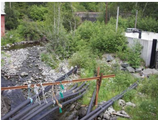
Figur 6: Uoversiktlig avløp (anlegget er per dags dato ikke i drift)
