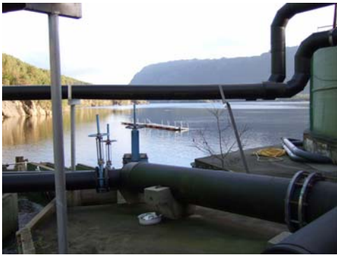
Figur 28: Flytebryggeløsning som nødvendiggjør føringsslanger i sjø
