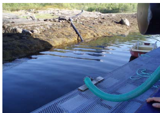
Figur 27: Føringsrør i sjø
