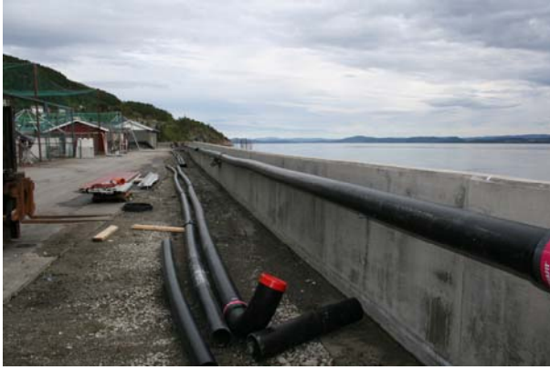
Figur 18: Sikring av anleggsområde
